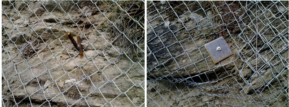
Ankertypen Schlaganker und Bohranker mit Platte
